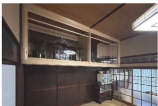
【O 様邸の神棚】 立派なお社をお祀りする神棚に 建具を施工
