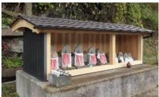
【但東町平田の地藏堂】 老朽化による祠の改築（雨樋も新設）
