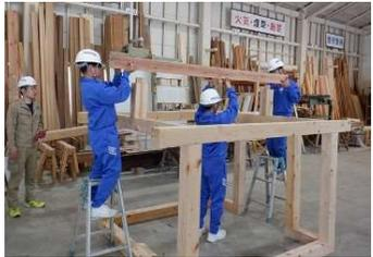
土台を組み、柱を立て屋根を組みます
