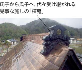
雨や空気に触れると銅の酸化は早く緑青の錆・膜で表面が覆われます古からの銅像や大仏が現存するように内部の腐食を防ぎます
