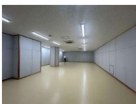
既存壁からの湿気などを防ぐ二重壁。不透湿施工方法と調湿パネル。建具は気密性を確保するものを使用しています
