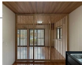
天井高みである木製建具 断熱性を高めるため 透明なアクリル硝子入り
